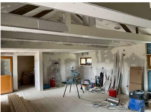
Der Umbau schreitet gut voran: die Wände wurden bereits verspachtelt. Aktuell stehen die Malerarbeiten und Wandverkleidung an. Anschließend werden die Bodenplatten verlegt. Im Außenbereich sind bereits die Pflasterarbeiten für die Dusche fertig.
